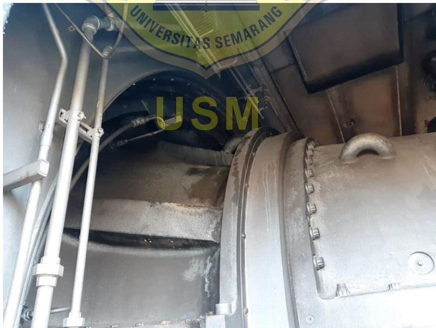
Gambar 2.5 Kompresor Unit GTG 2.3
